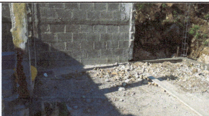
Foto: 3 en esta fotografia se observa los inicios de los trabajos.
