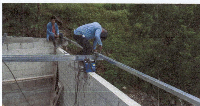
Foto: 2 colocacion estructura de soporte para la cubierta de lamina.
