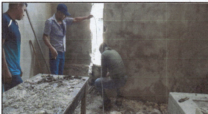
Foto: 4 reforzando la estructura del edificio escolar.
