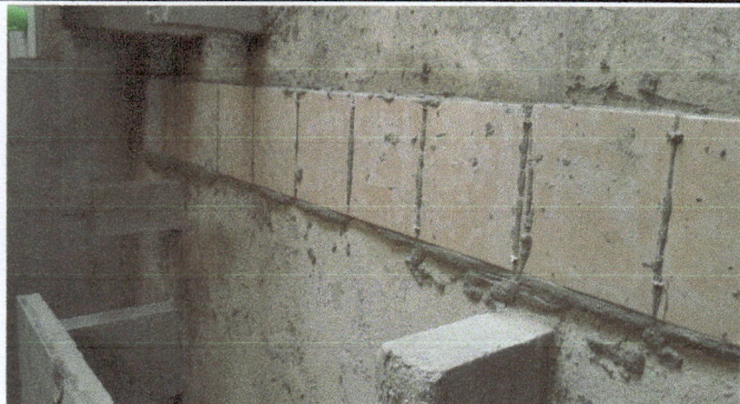
Foto: 1 Se observa la sustitución de losa de piso por piso cerámico.
