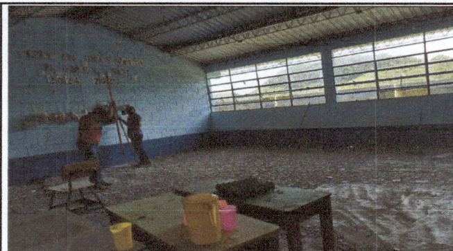
Foto: 6 Se observa los trabajos realizados previo a la colocación del piso cerámicos
